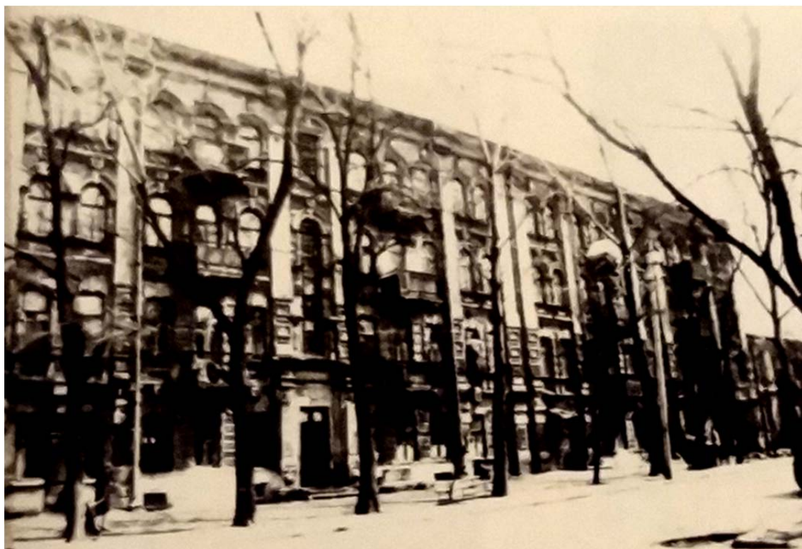
17. Пам'ятка архітектури по вул. Харківській, № 6 – Прибутковий будинок Померанца. Фото сер. 1970-х рр.
