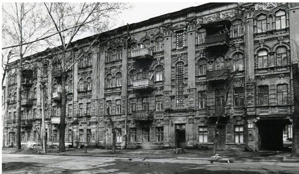
18. Пам'ятка архітектури по вул. Харківській, № 6 – Прибутковий будинок Померанца. Фото сер. 1980-х рр.
