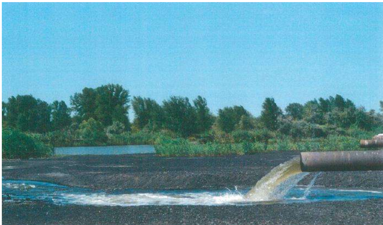
Мал. 5 – Шлакопроводи шлаконакопичувача
