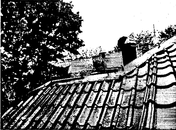
Опис фото №7 улаштування металочерпиці
