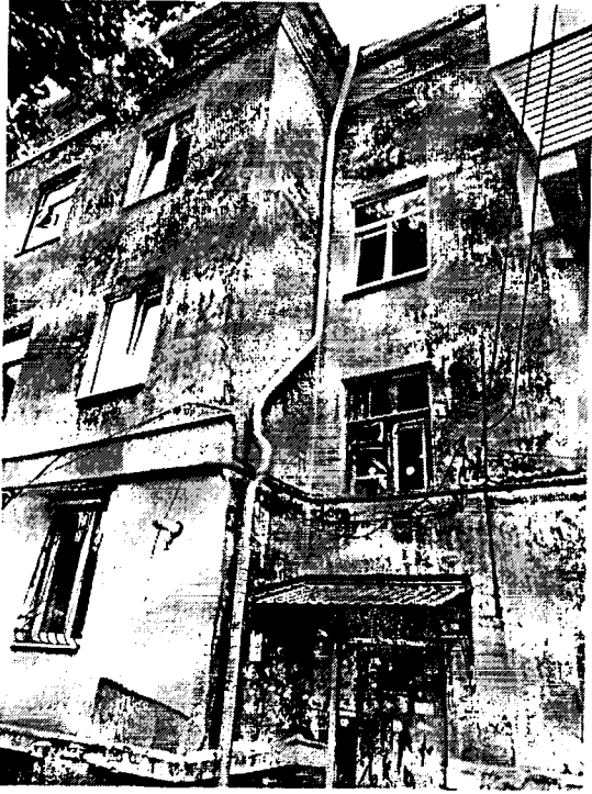
Опис фото № 15 улаштування водостічної системи
