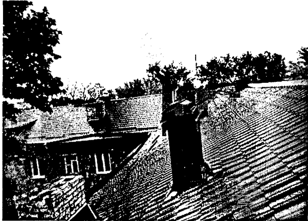
Опис фото №8 улаштування металочерпиці
