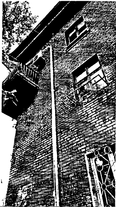
Опис фото №13 улаштування водостічної системи та блискавкозахиста
