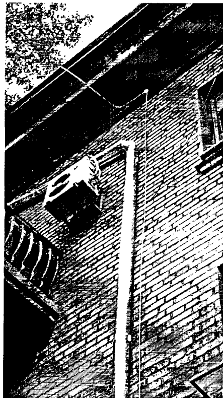
Опис фото №14 улаштування водостічної системи та блискавкозахиста
