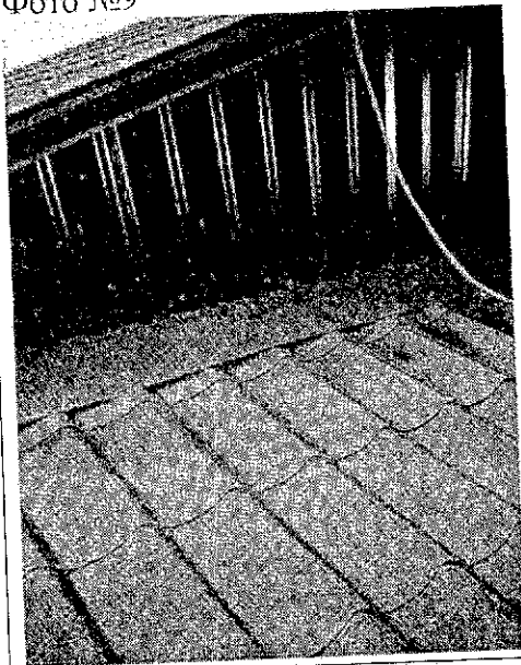
Опис фото №9 улаштування металочерепиці
