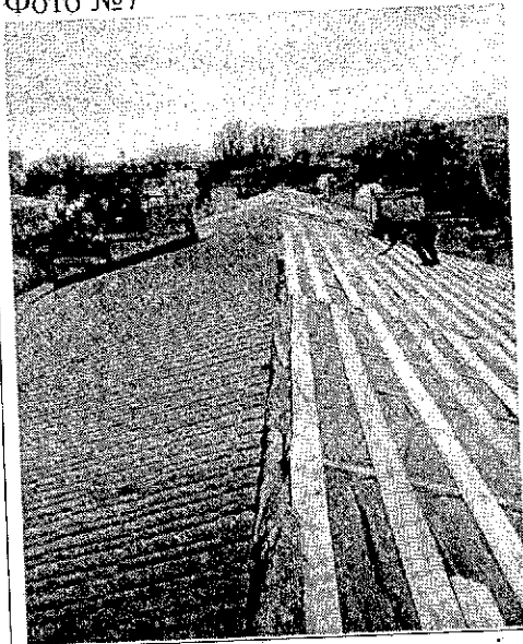
Опис фото №7 улаштування плівки «гідробар'єр» та обрештування
