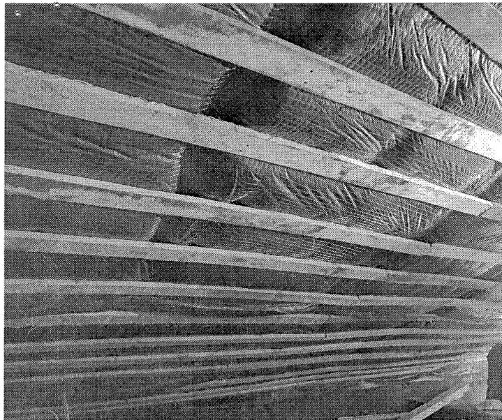
Опис фото №5 Улаштування паро- та гідробар'єру. Утеплення перекриттів мінеральною ватою
