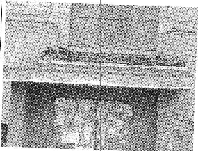
Опис фото №5 Улаштування покриття з листової сталі тільки скатів
