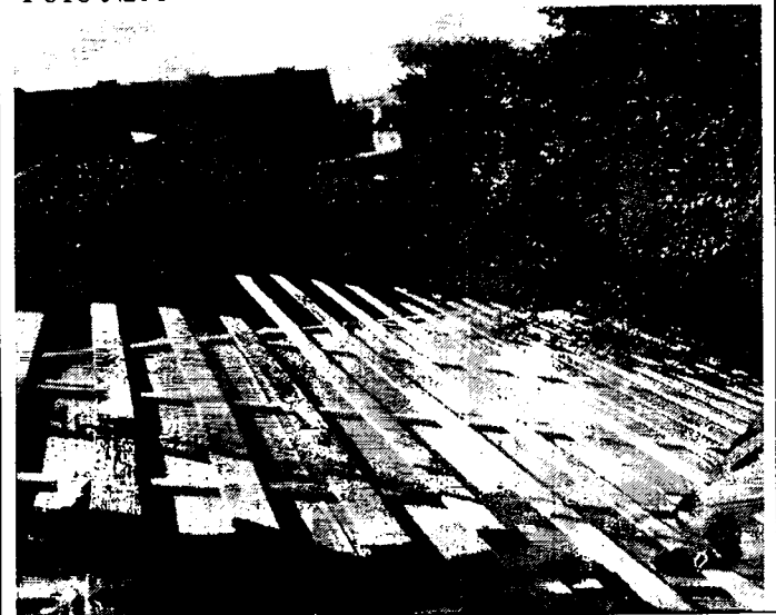
Опис фото №10 Влаштування обрешетування
