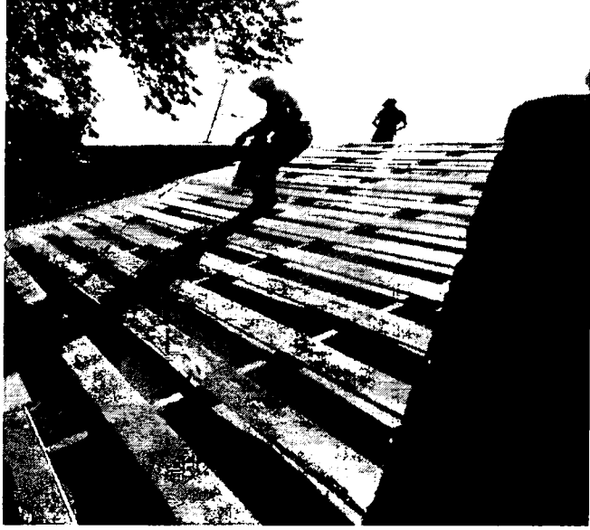
Опис фото №11 Біозахист дерев'яних конструкцій
