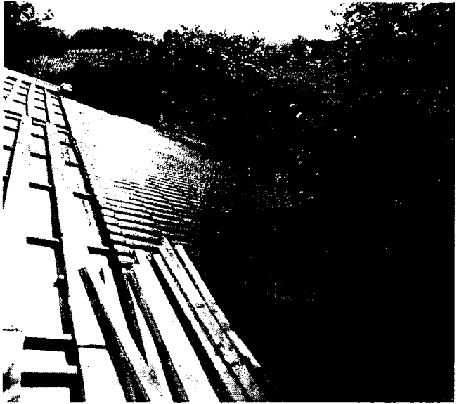
Опис фото №14 Влаштування металочерпиці
