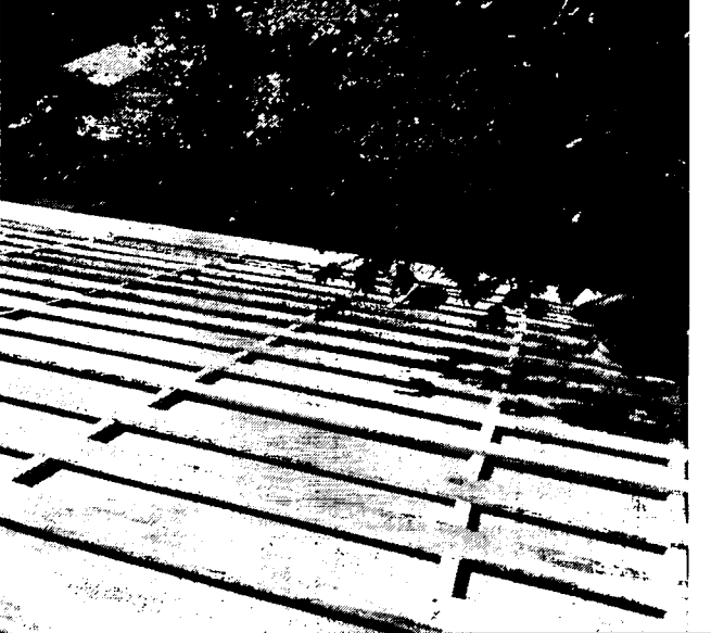
Опис фото №9 Влаштування обрешетування
