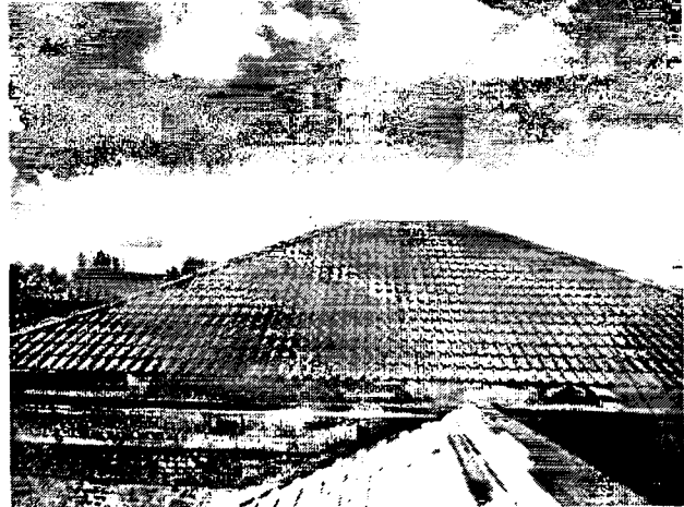
Опис фото №14 готова покрівля, улаштування конька та зливів
