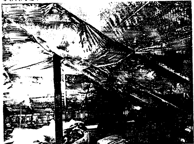
Опис фото №4 улаштування плівки «паробар'єр» та утеплювача
