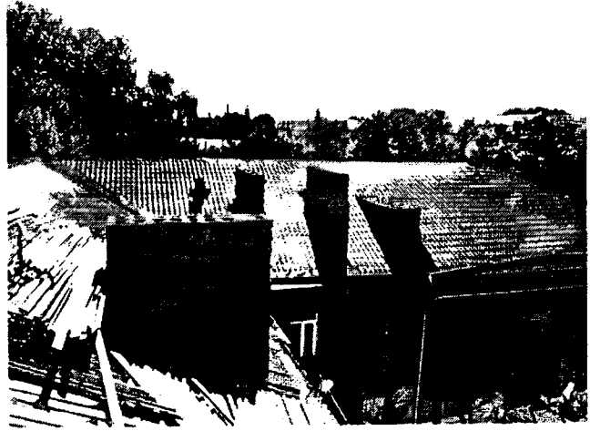
Опис фото №12 улаштування металочерепиці
