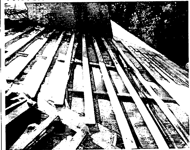
Опис фото №10 улаштування плівки «гідробар'єр» та обрештування
