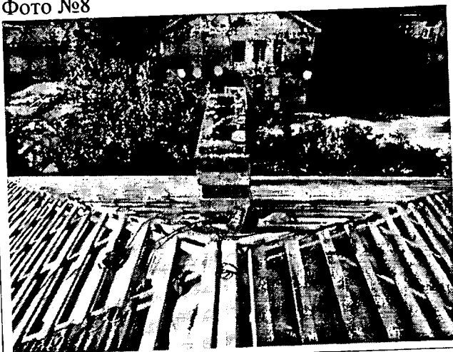
Опис фото №8 улаштування обрешетування
