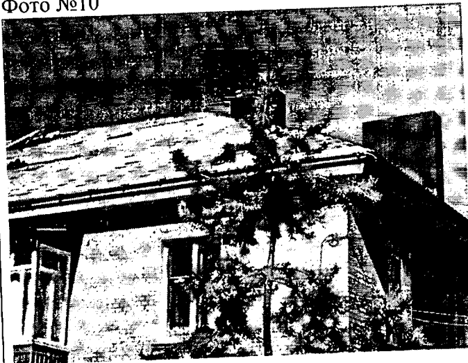
Опис фото №10 улаштування обрешетування та металочерпиці
