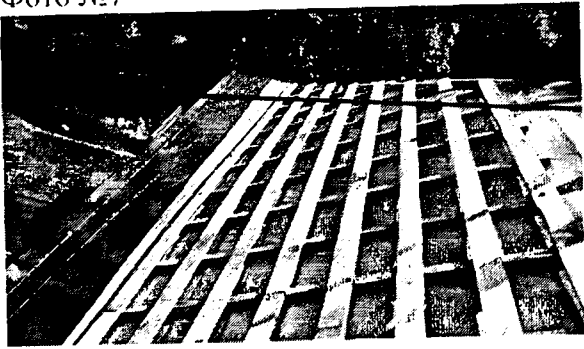
Опис фото №7 улаштування обрештування
