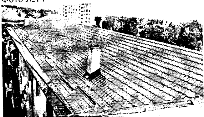
Опис фото №14 улаштування металочерепиці, зливу та сніготримачів
