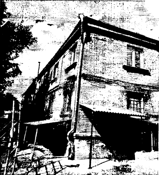
Опис фото №15 Влаштування водостічки
