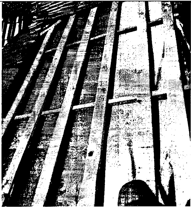
Опис фото №9 Влаштування обрешетування
