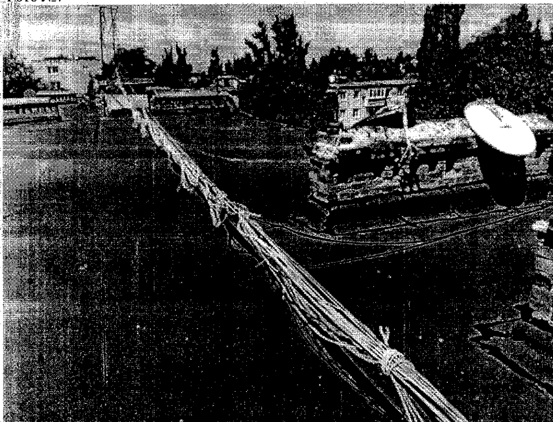
Опис фото №7 готова покрівля
