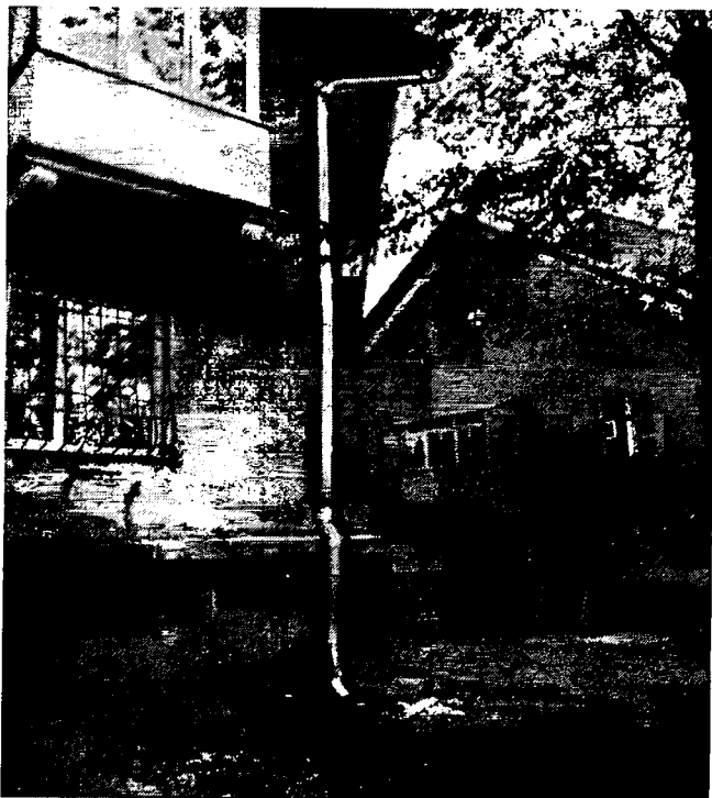
Опис фото №15 Влаштування водостічки
