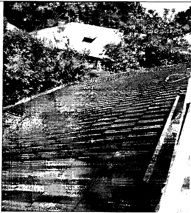
Опис фото №13 Влаштування металочерепиці
