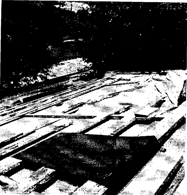
Опис фото №3 Влаштування плівки «гідробар'єр»
