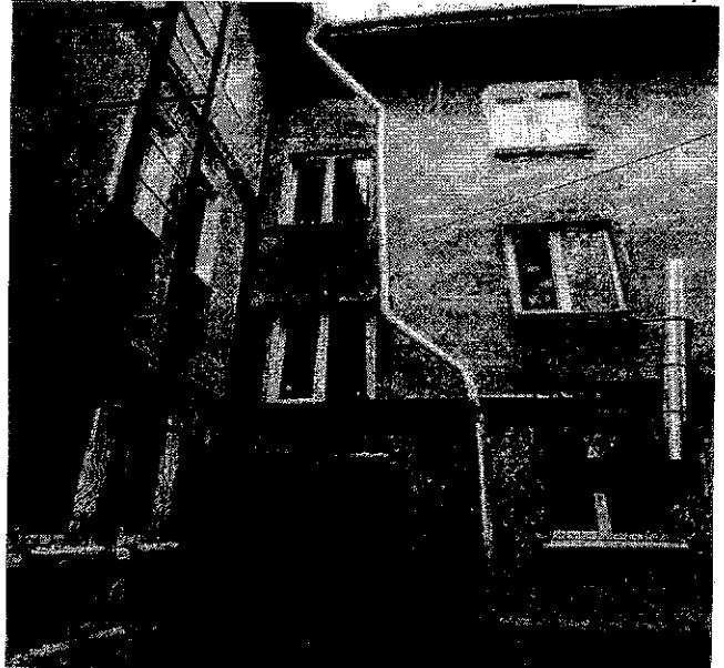
Опис фото №16 Влаштування водостічки
