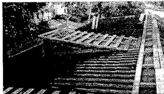
Опис фото №6 улаштування обрештування та металочерепиці
