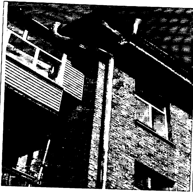
Опис фото №15 Влаштування водостічки
