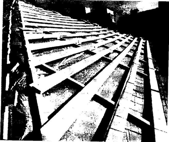
Опис фото №7 Укладання плівки гідробар'єру та обрешетування
