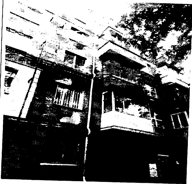
Опис фото №15 Влаштування водостічки
