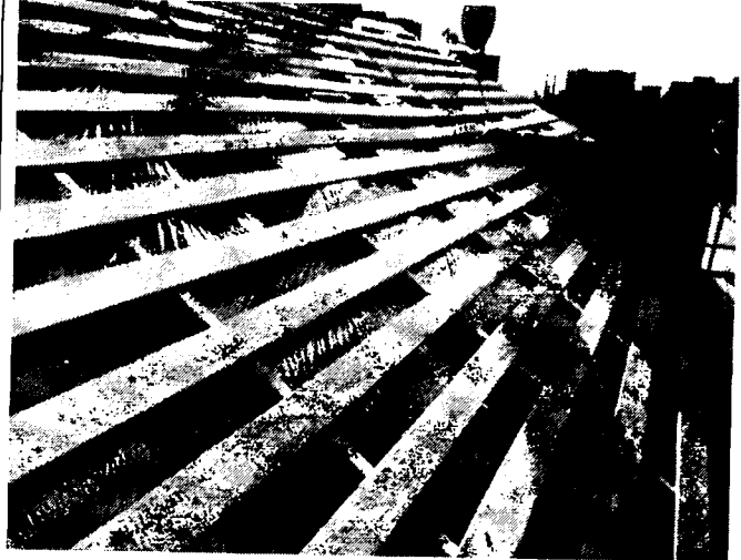
Опис фото №10 Влаштування обрешетування
