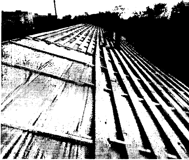
Опис фото №11 Влаштування обрешетування
