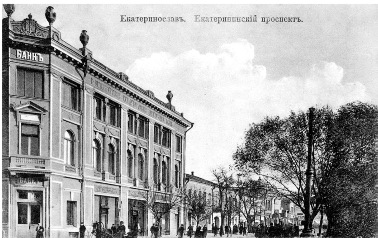
Загальний вигляд фронту забудови даного кварталу вздовж проспекту від перехрестя з нинішньою вулицею Воскресенською. На передньому плані будинок Катеринославського відділення Санкт-Петербурзького міжнародного комерційного банку (нині вул. Воскресенська, № 13). Фото сер. 1910-х рр.
