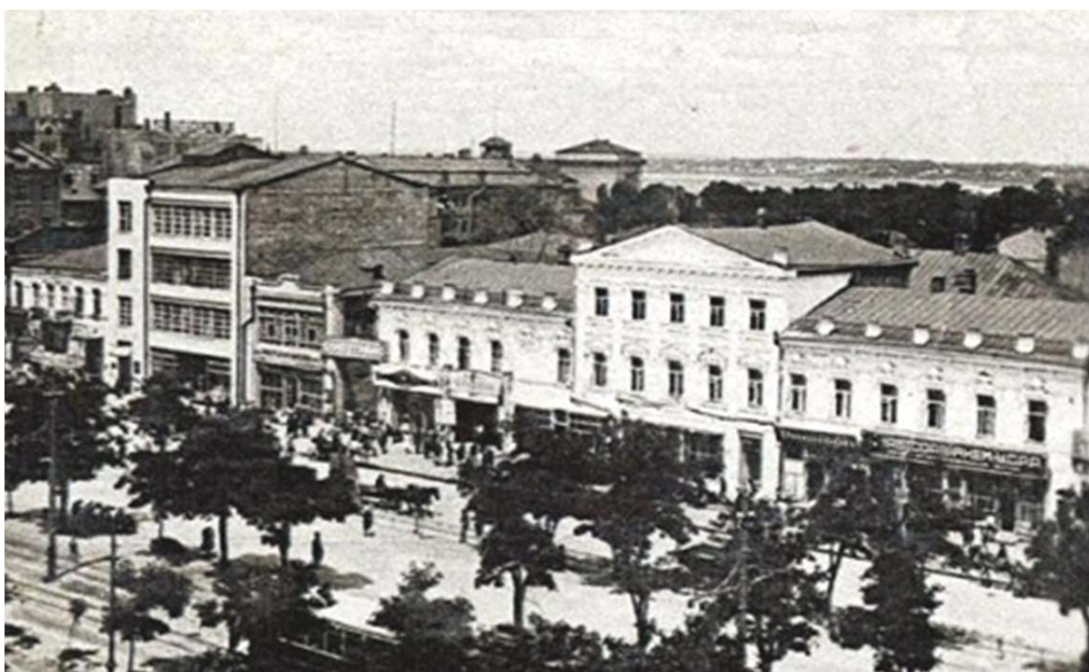
Вигляд забудови середньої частини сторони даного кварталу вздовж проспекту. На передньому плані колишній будинок Трояновського на місці нинішнього будинку просп. Дмитра Яворницького, № 54. Фото 1930-х рр.
