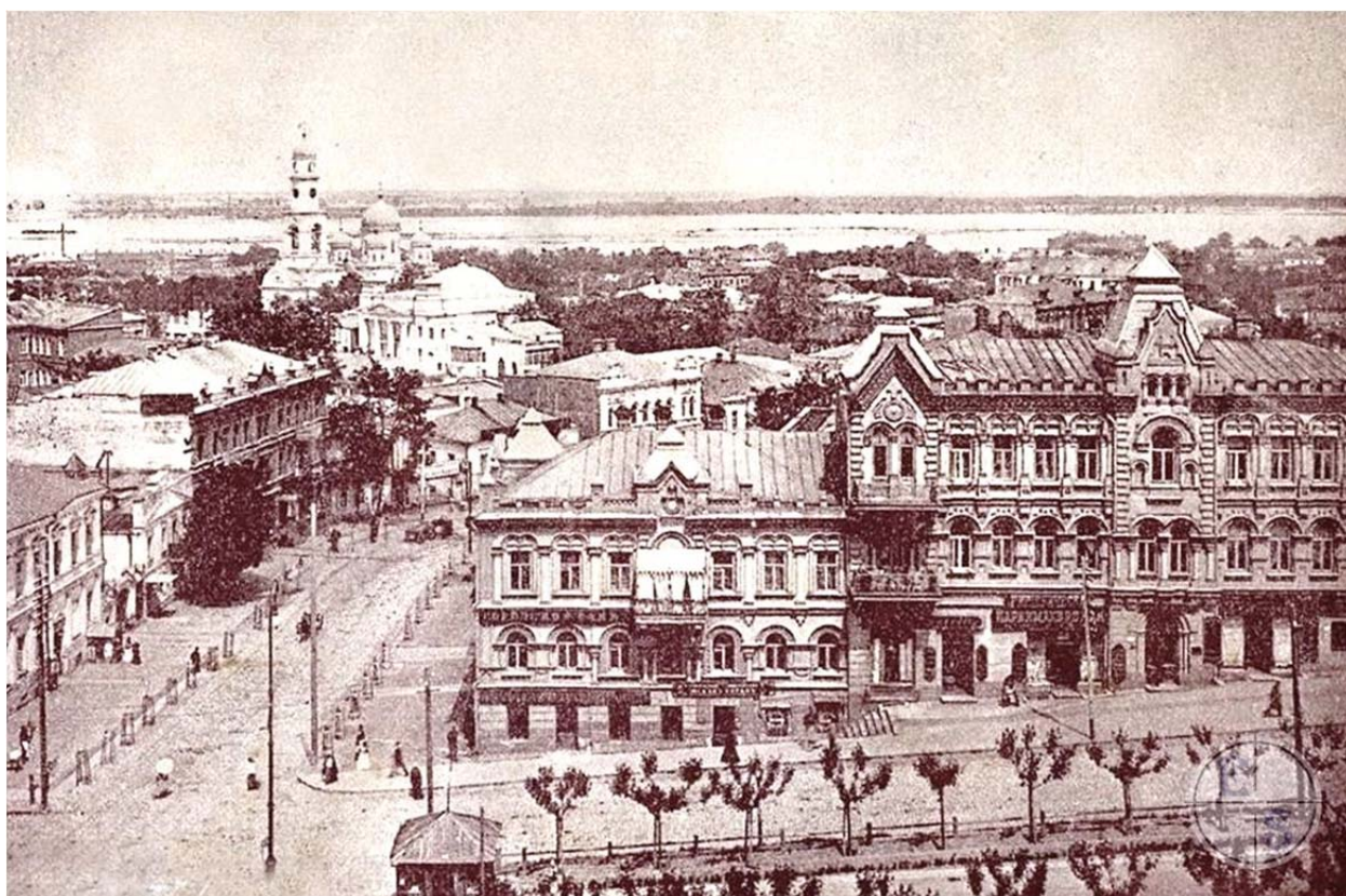
7. Забудова кутової частини даного кварталу (праворуч) поблизу перехрестя з нинішньою вулицею Барикадною. Обидва будинки збереглися (вул. Барикадна, № 2 та № 2, корпус 1). Фото 1900-х рр.
